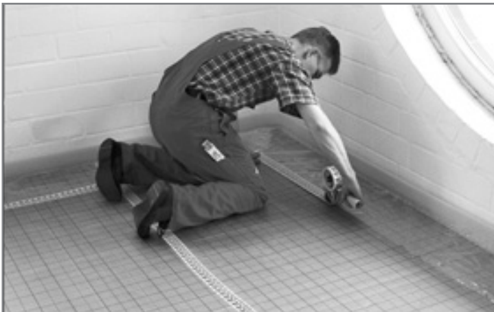
Уплотнение краевых изоляционных полос
