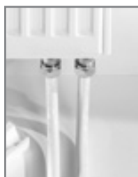
Подключение радиатора с использованием направляющего уголка
