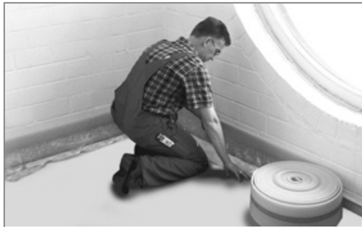
Укладка демпферной ленты
