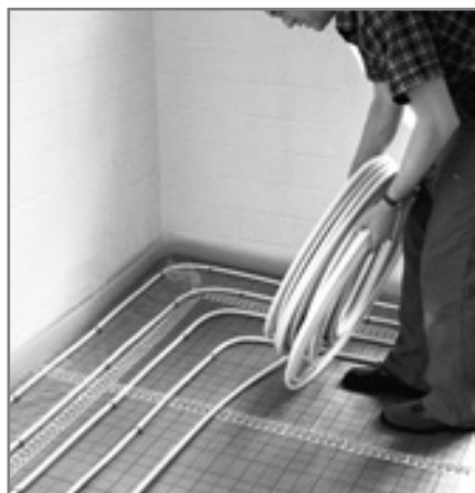
Укладка трубопровода
