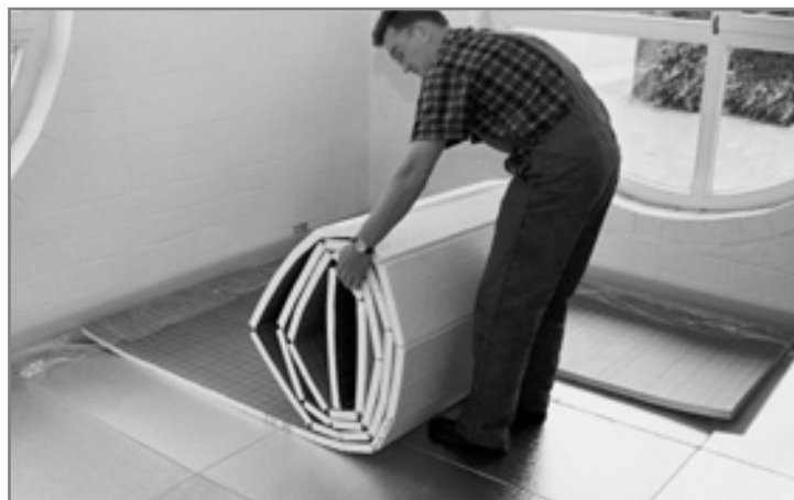
Укладка рулонной изоляции
