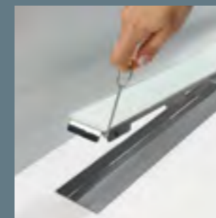
Извлечь панель с помощью крючка
