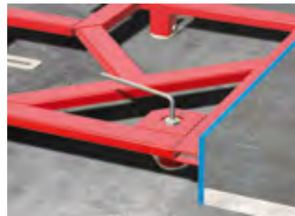
Выравнивание монтажной рамы по горизонтали.
