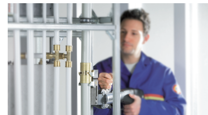
Использование электро-прессового инструмента с насадкой TECE
