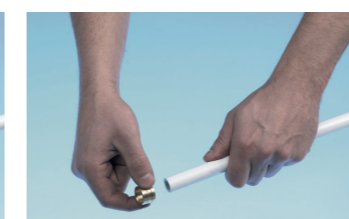
Нанизывание натяжной гильзы на трубу
