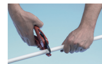
Отрезание трубы при помощи труборезных ножниц
